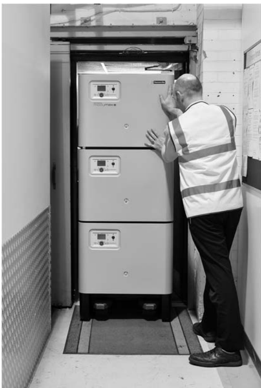
Figura 2.2 – Posizionamento della caldaia
