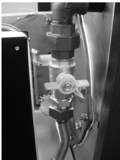
Figura 7.2.1 – Valvola del gas (l'illustrazione raffigura 100/114)
