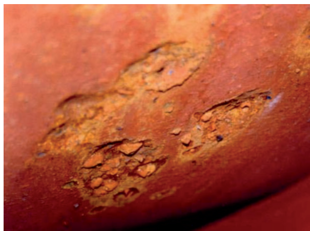
Foto de corrosión cáustica
