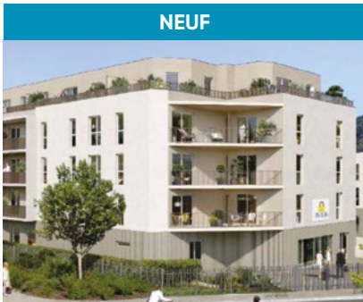
Résidence Séniors (Challes les Eaux - 73)
