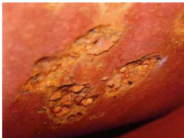
Foto de corrosión cáustica.
