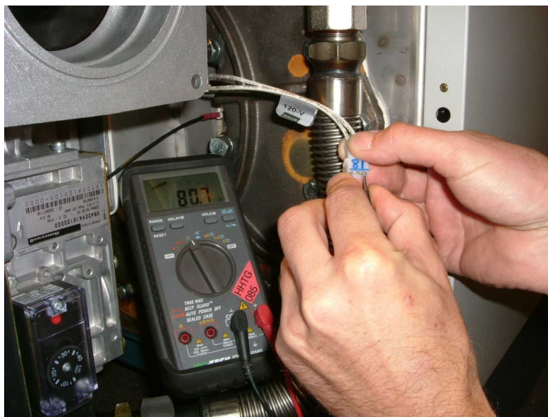
Figuur 7.2.3 – Controle ontstekingsmechanisme (200c/ 250c afgebeeld met luchtfilter verwijderd)
