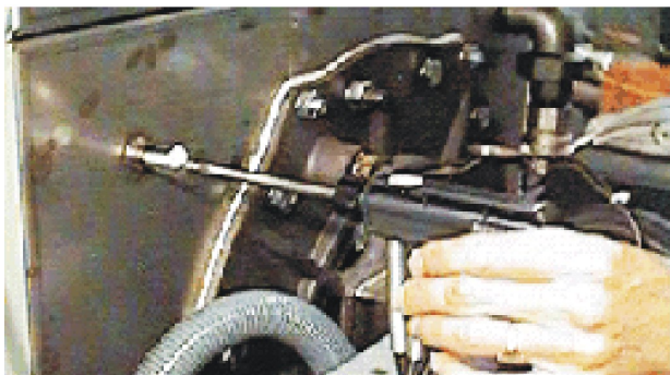
Figuur 8.6.3 – Inbrengen van de analysesonde
