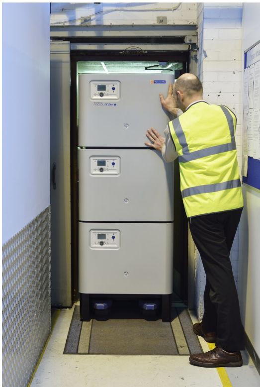
Figuur 2.2 – Plaatsing ketel
