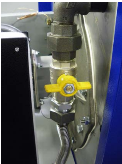
Figura 7.2.1 - Válvula de gas (foto modelos 100/120)
