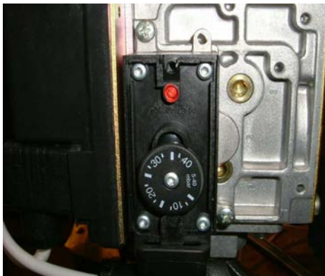
Figura 8.1.2 - Presostato de mínima presión de gas
