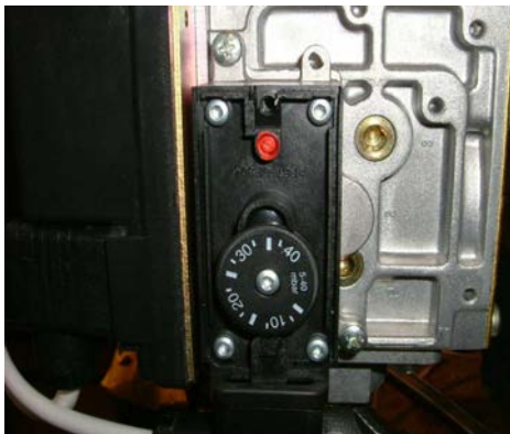
Figura 8.1.2 - Presostato de mínima presión de gas
