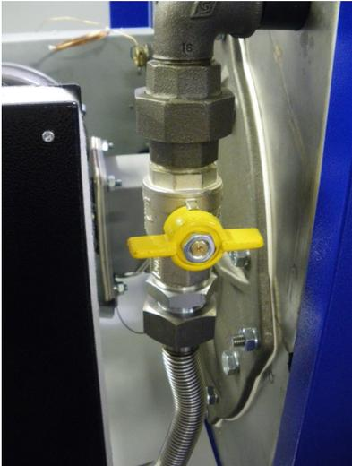
Figure 8.1.1 - Robinet d'arrêt de gaz
