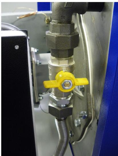
**Figure 7.2.1 - Position du vanne gaz (chaudière 100/114)**
