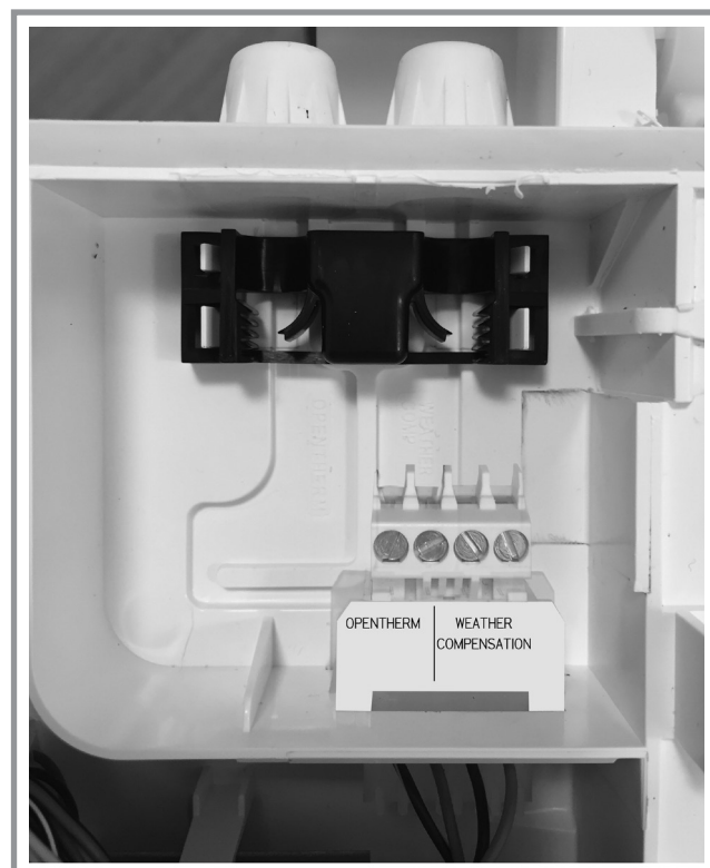
figura 34 - Collegamenti installatore. (Lato destro)
