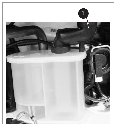
figura 47 - Tubazione in gomma di drenaggio della vaschetta
