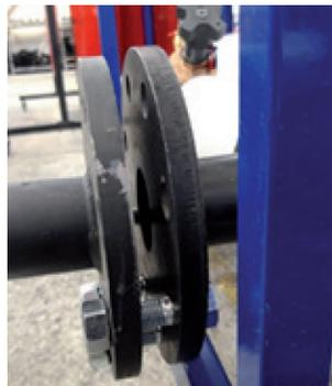
Positionner le clapet en veillant au sens de passage du fluide qui est indiqué sur le corps par une flèche. Celle-ci doit être orientée vers la chaudière.
