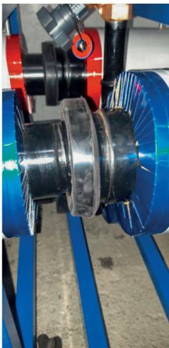
Positionner et rassembler les colliers. Une fois mis en place, procéder au serrage à l'aide d'une clé N°22.
