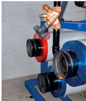
Positionner les joints en laissant dépasser le collecteur afin de faciliter l'assemblage avec le prochain module.
