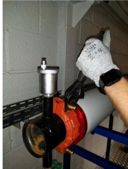
Coloque la abrazadera y el obturador y apriete.
