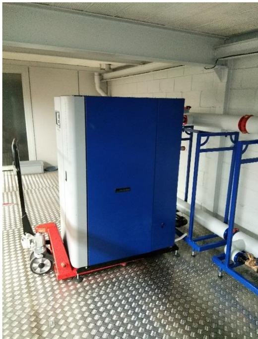
Tras desembalar las calderas, utilizando una transpaleta se coloca el Varmax frente a los packs hidráulicos, asegurándose de alinear las salidas de las calderas con las tomas hidráulicas.
