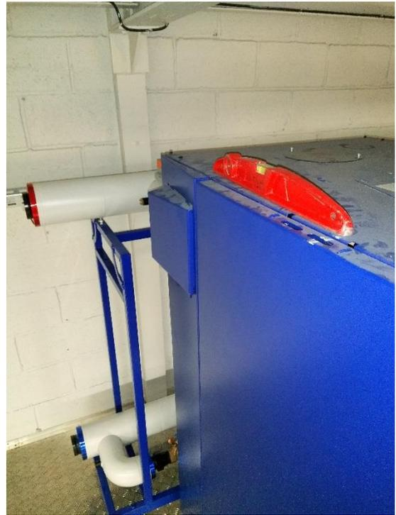
Los racores se ensamblan para 120-140 kW apretando manualmente las primeras roscas y luego con una llave de garras para el apriete final. Las bridas se fijan con pernos en los otros modelos.
