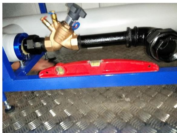
Ya con el módulo nivelado, afloje y quite las abrazaderas ranuradas montadas en fábrica. Por defecto se ponen en los colectores, a la derecha del módulo.
