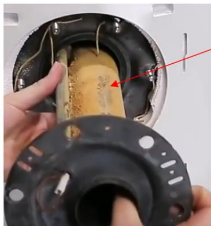
Corps de chauffe pour chauffe-eau stéatite
