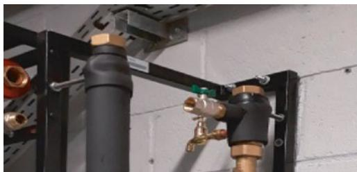
Raccordement de l'entrée et de la sortie de l'adoucisseur **Rep 3** et **Rep 4**.
