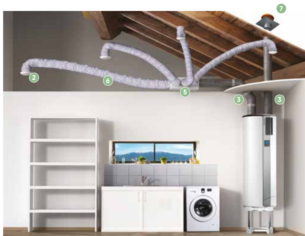
Réseau pieuvre en volume non chauffé (le réseau d'extraction et de rejet doit impérativement être isolé thermiquement).
