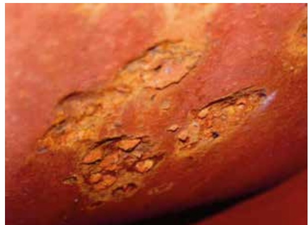
Foto de corrosión cáustica.
