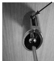
**5** Vissez les plots sur les tubes sans les bloquer. Vérifiez leur positionnement en les mettant avec le radiateur sèche-serviettes dans les fourreaux. Une fois la position trouvée, bloquez les vis de chaque plot.
