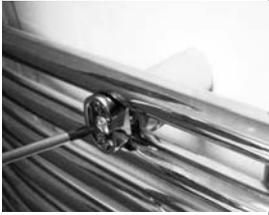
**6** Mettez le radiateur sèche-serviettes au mur dans les fourreaux. Vissez chacune des vis de blocage. Mettez les capuchons au bout des plots.
